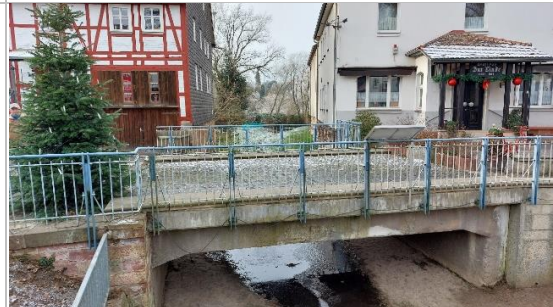
Brücke über den Schwarzenbach im Angerbereich
