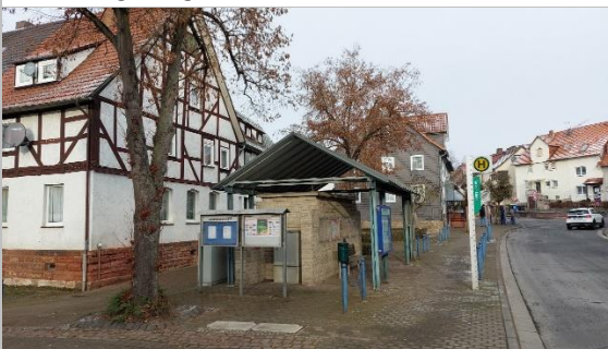
Platzbereich mit Trafohaus
